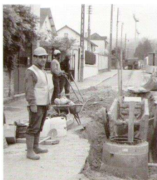
Travaux dans la rue des Célestins (au niveau des n° 30-33)
