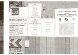
5 Heureusement, quelques logements sociaux viennent d'être achevés ou sont en cours de construction. L'inauguration du Clos des Tilleuls, le 29 juin, permet au Maire de réaffirmer sa volonté de favoriser la mixité sociale. Le chantier du centre du quartier est celui d'une HLM.
